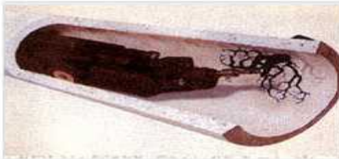
Cuttingロボットで木の根、突出物を除去
